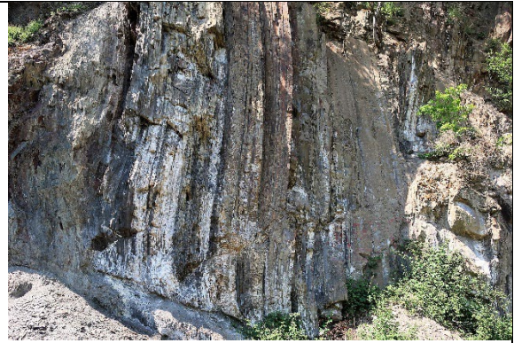
Abbildung 29: Ziegelsteinbruch in Hagen-Vorhalle. Deutlich zu erkennen sind die einzelnen, gefalteten und tektonisch senkrecht gestellten Gesteinsschichten (Wikimedia-Bewegung – Bärwinkel, K. o. J.).
